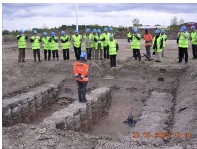
Figur 2 Framschaktade kalkcementpelarskivor.
